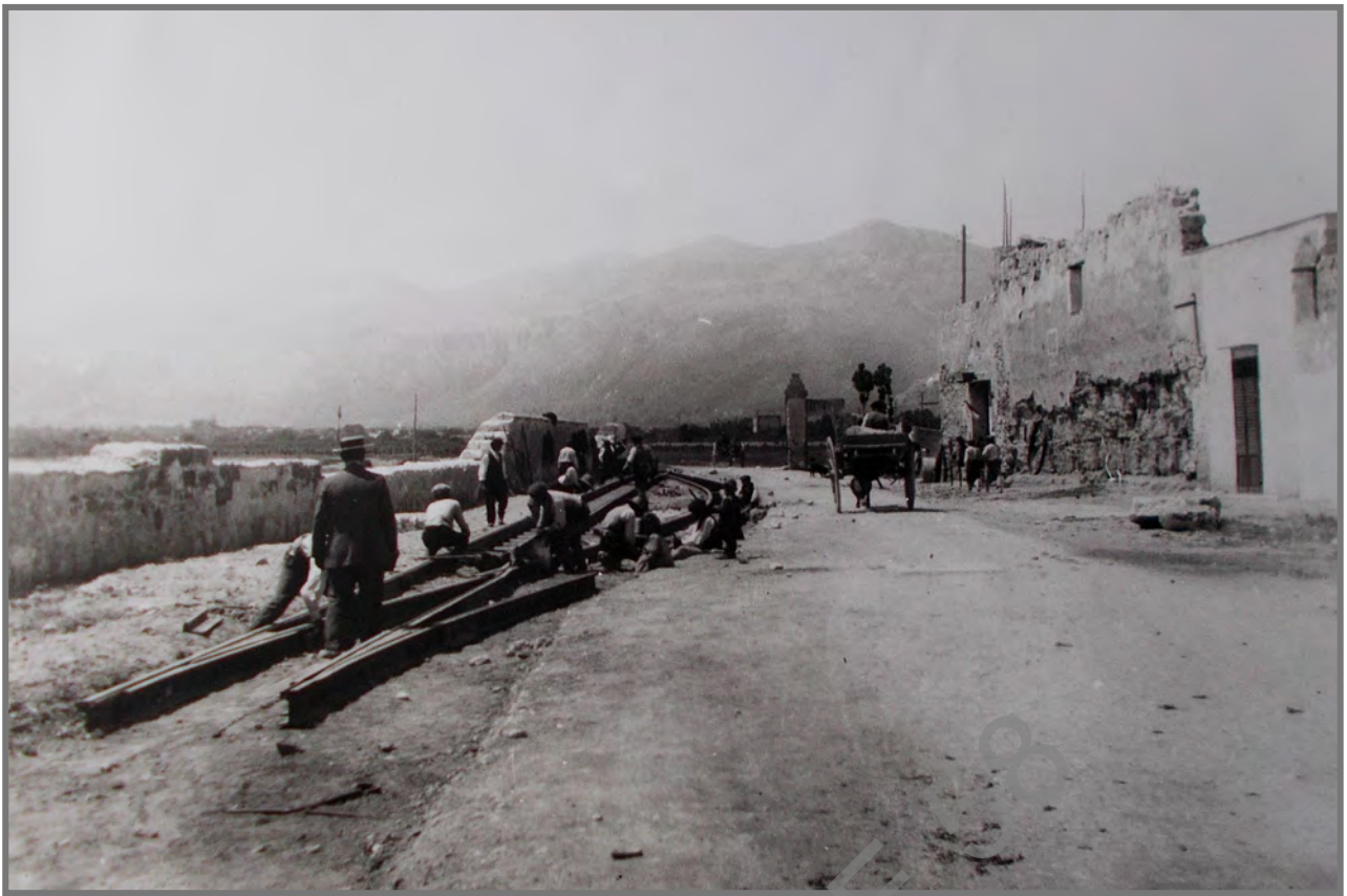
Mondello paese, posa dei binari del tram, anno 1910
