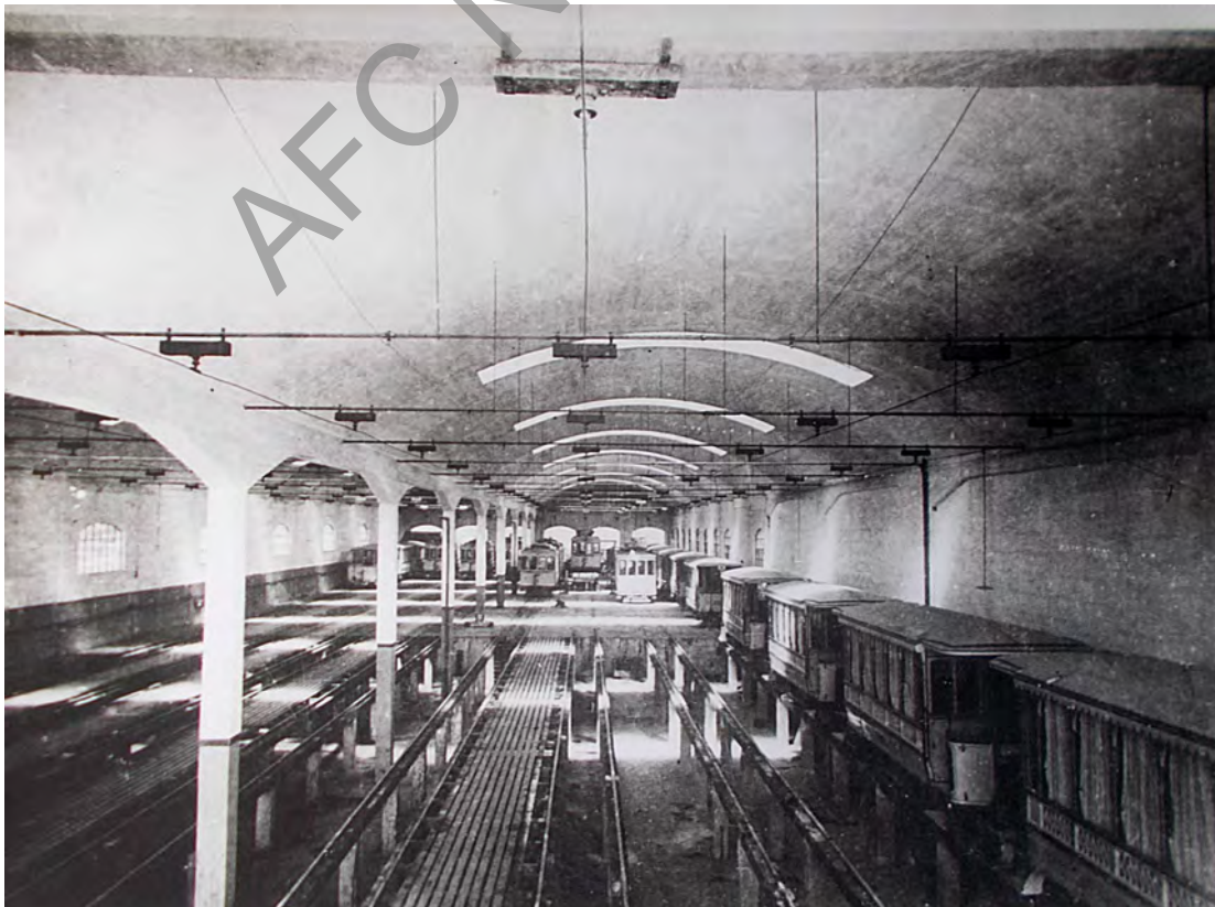
Rimessa dei tram, "Deposito delle Croci", anno 1914
